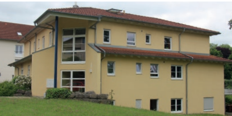
Parterre-Wohnung in der Domänenstraße 8, 88069 Tett nang
